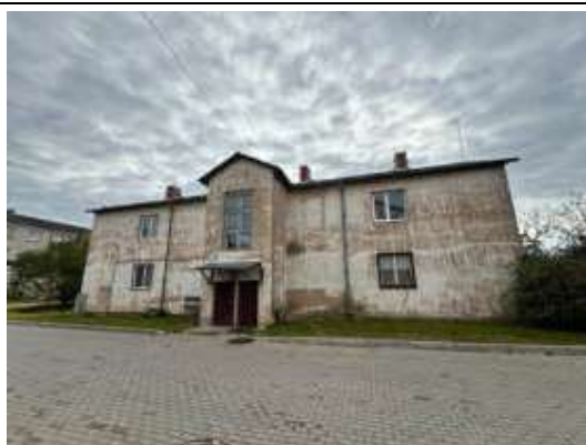
Dzīvojamā māja Liepājas ielā 24
