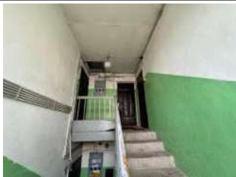
2.stāva kāpņu telpa
